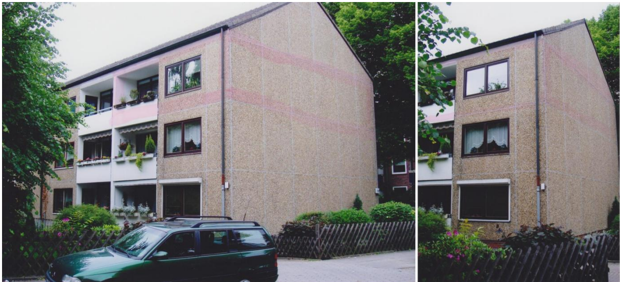
Abbildung 2: Außenansichten des zweistöckigen Wohngebäudes der WEG. Bausubstanzbedingte Wärmeverluste treten größtenteils über Wärmebrücken oberhalb der Wohnung im 2. OG auf.
